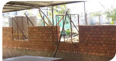
Ausbau des Pausenraums
